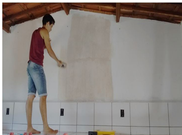
Figura 8. Aspecto inicial da parede de alvenaria para o estudo de caso.
