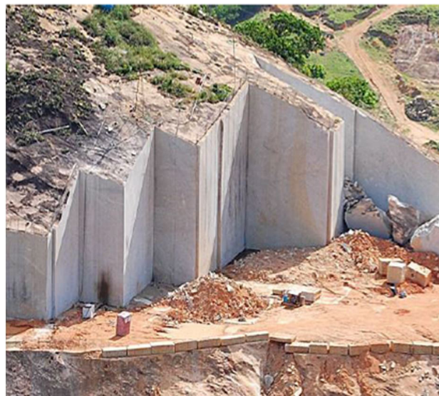
Figura 1. Painéis verticais em uma pedreira no Espírito Santo [4].
