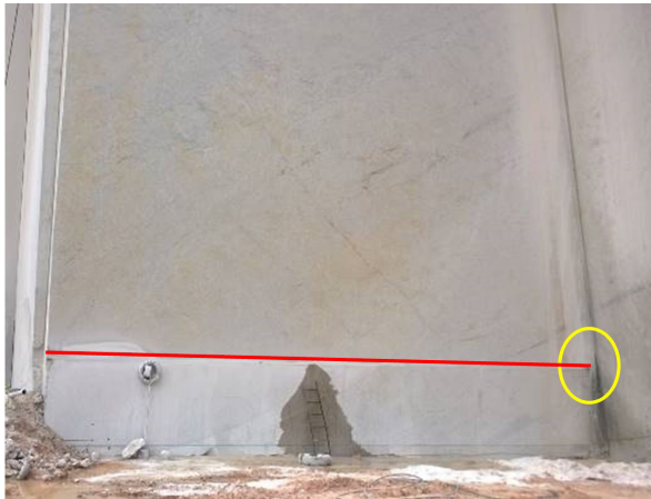
Figura 6. Imagem frontal da “boca de lobo” cortada com fio diamantado (em destaque, em vermelho), assim como pode ser visto em amarelo o furo inclinado.
