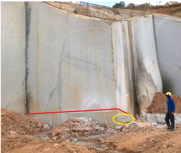
Figura 7. “Boca de lobo” cortada com fio diamantado em vermelho e perfuração lateral para inserção de explosivos em amarelo.
