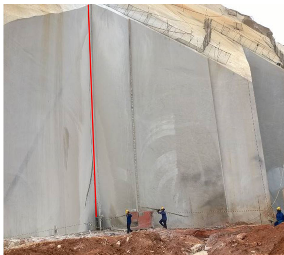
Figura 3. Em vermelho corte com fio diamantado na vertical, da região trincante do painel vertical.
