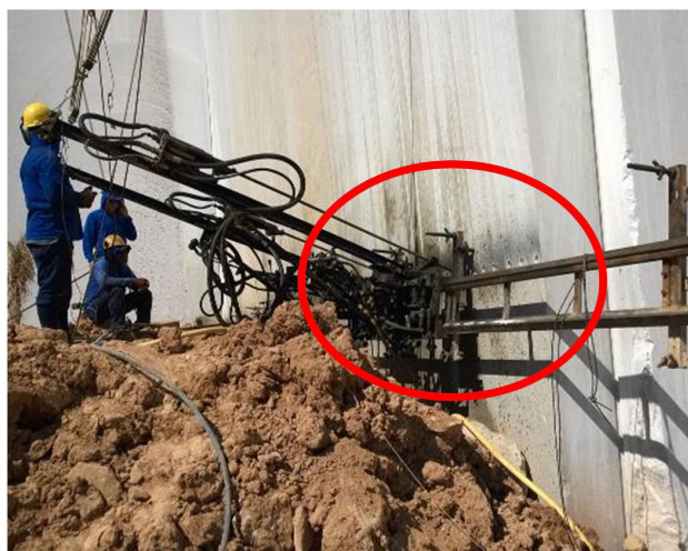
Figura 4. Perfuração inclinada com martelo pneumático (destacado em vermelho), com ângulo aproximado de 30° para formar a “boca de lobo”.
