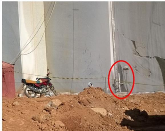
**Figura 3.** Em vermelho é possível observar o fluxo de água, durante a execução do corte com fio diamantado.
