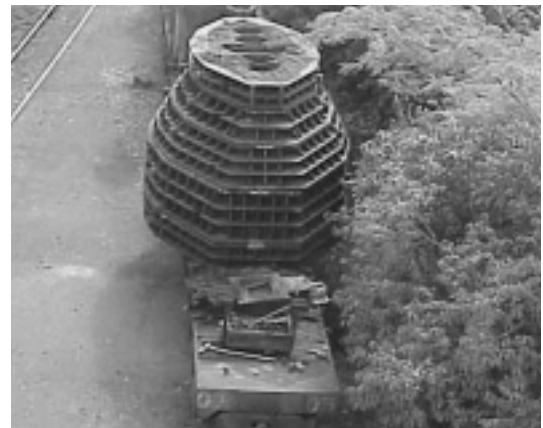
Figura 8. Vazamento do molde com panela da Aciaria.
