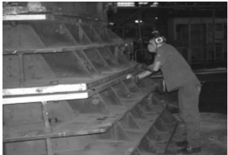
Figura 3. Parafusos para travamento dos moldes.
