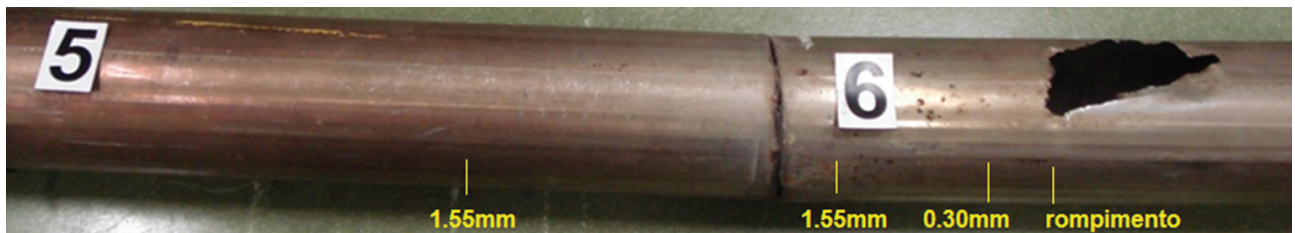
Figura 3. Perda de espessura crítica na região da amostra 6.
